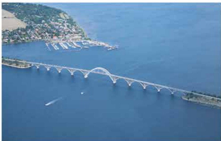
Dronning Alexandrines Bro, Mønbroen.jpg
