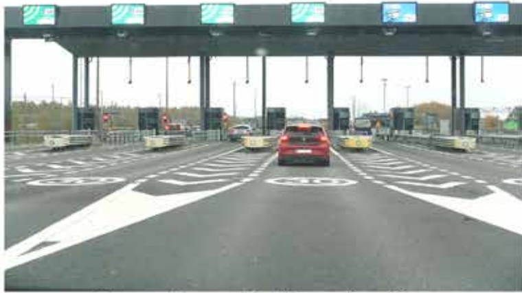
Øresundsbroens betalingsanlæg 2.jpg
